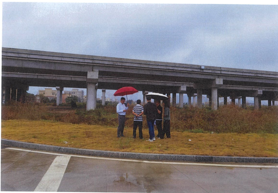
项目现场照片
