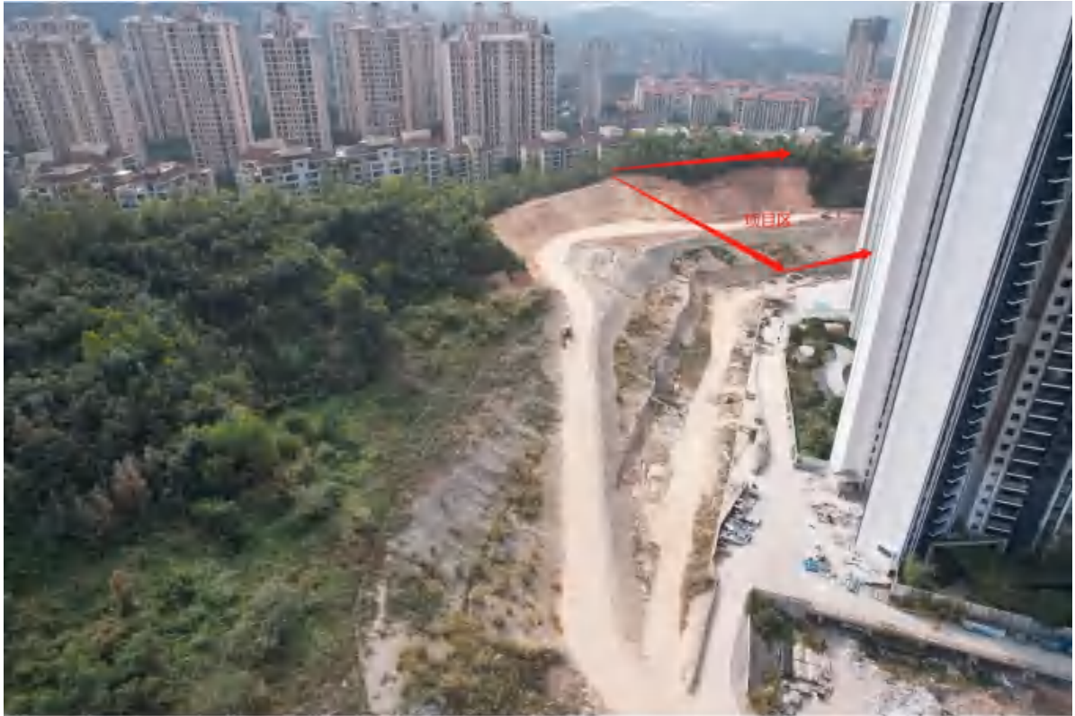
施工现场开挖前（时间：2024年1月10日）
