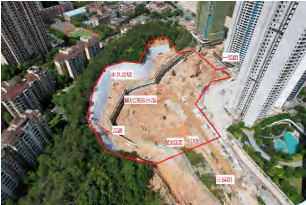
图 3.3-1 工程占地内已实施的基坑顶部排水沟措施
