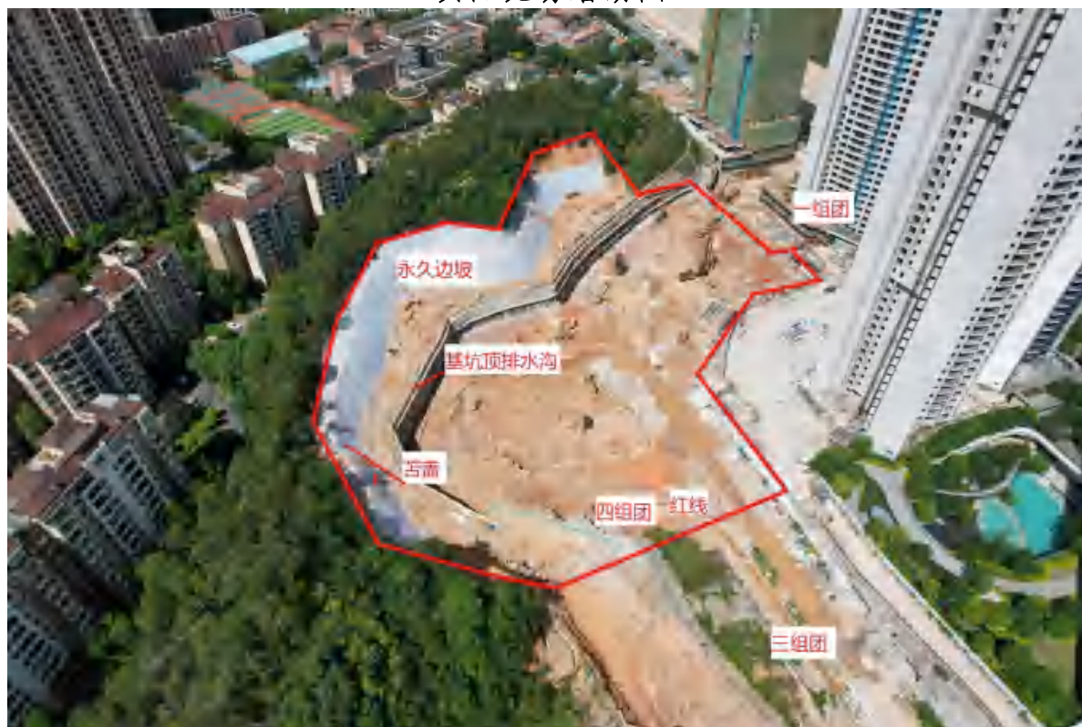
施工现场（时间：2024年6月28日）
