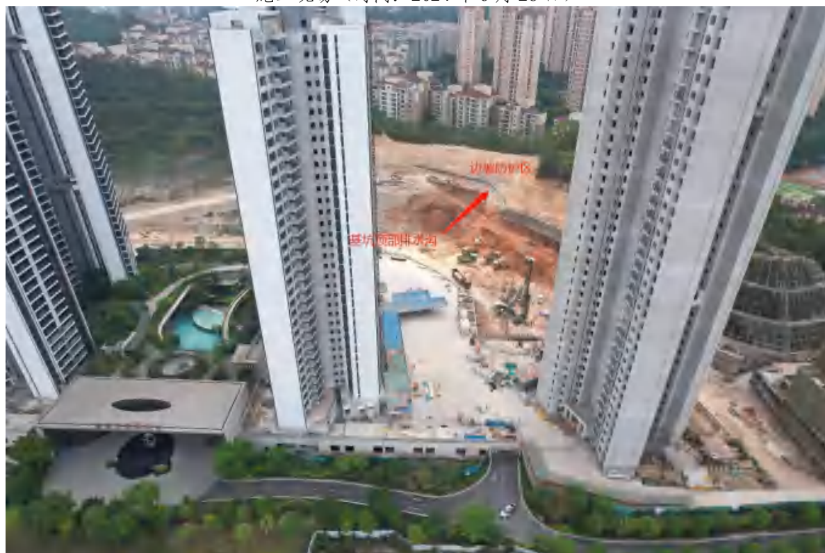
施工现场（时间：2024年4月20日）
