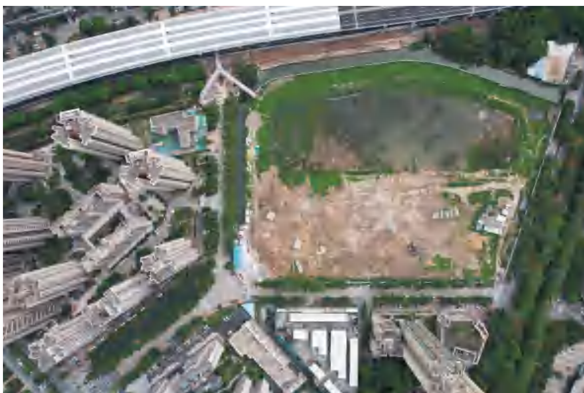
施工整体现场
