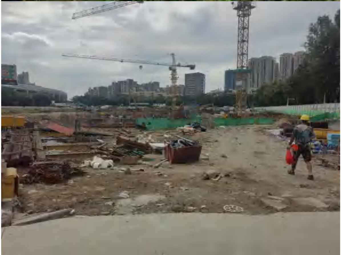
基坑开挖现场
