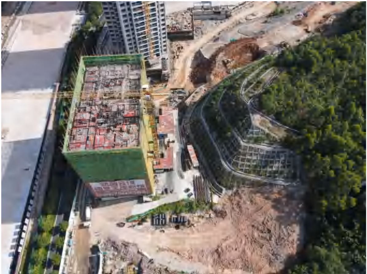
南侧高边坡开挖前（时间：2024年1月10日）
