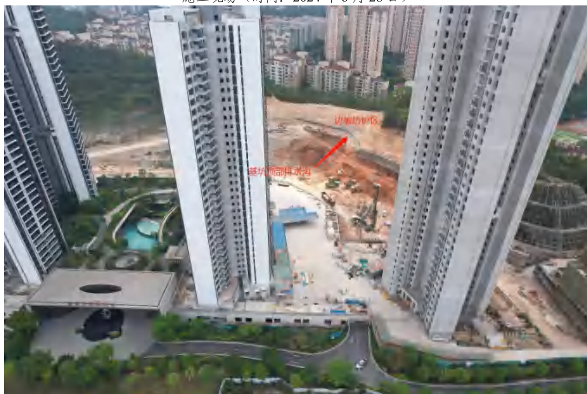
施工现场（时间：2024年4月20日）
