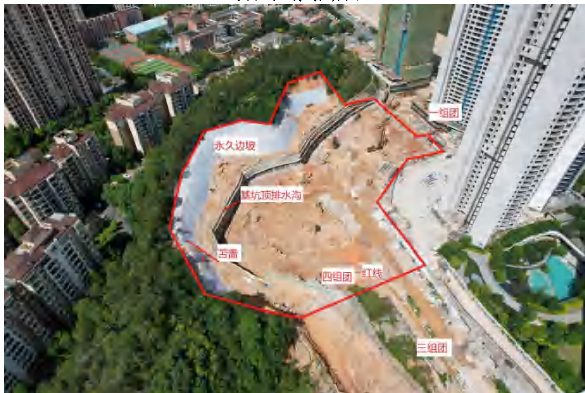
施工现场（时间：2024年6月28日）
