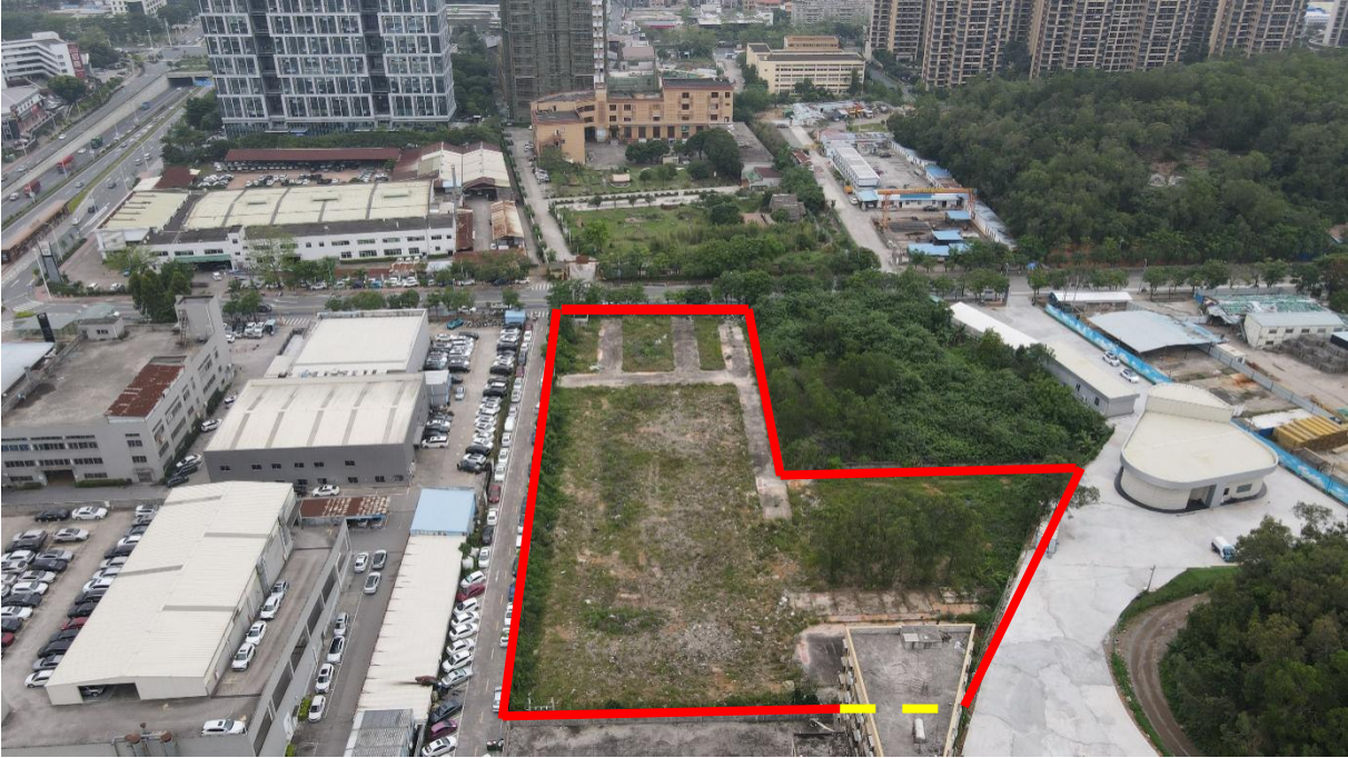
项目东西两侧现状
