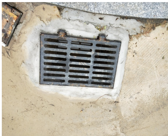
小区内排水口
